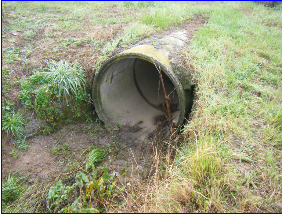
Figura 13 – Tubazione Ø 110 cm con cui il Fosso Arrù sottopassa Via del Terzo (vista verso valle)
