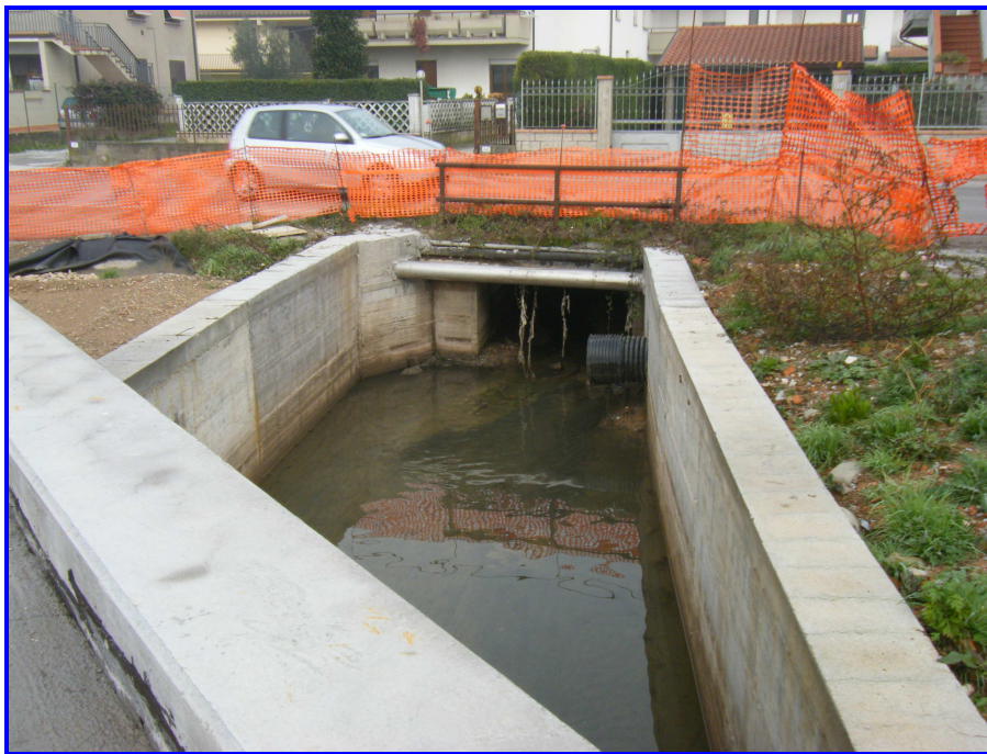
Figura 14 - Sbocco del Fosso Arrù da sotto Via del Terzo (vista verso monte)
