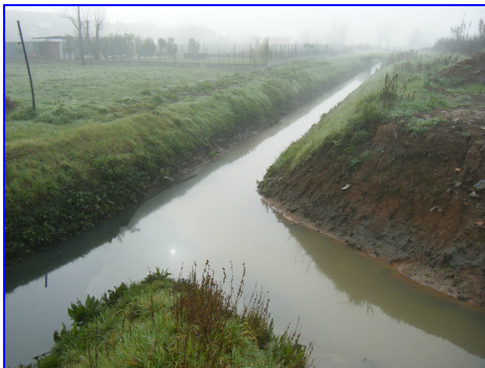
Figura 15 - Confluenza fra Fosso Arrù e Rio Pratovecchio, così come modificata dai lavori per la realizzazione della nuova viabilità (vista verso valle)
