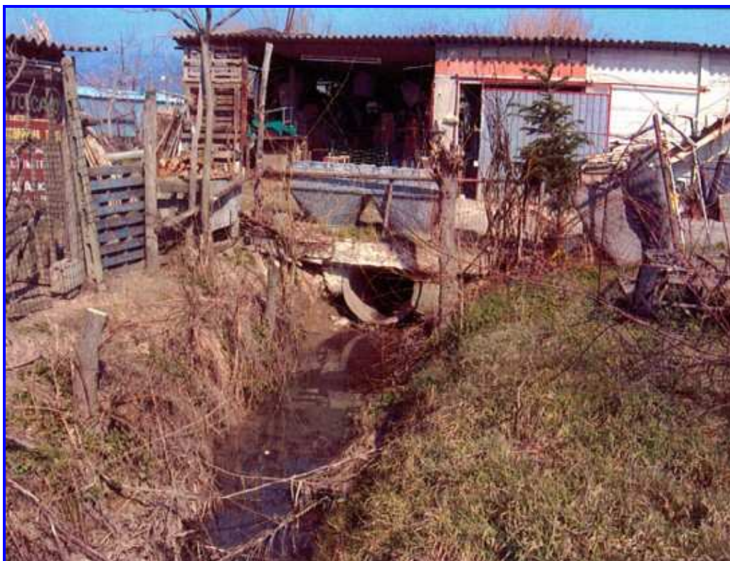
Figura 12 –Passaggio del Fosso Arrù sotto la rimessa agricola presente con Ø 60 cm
