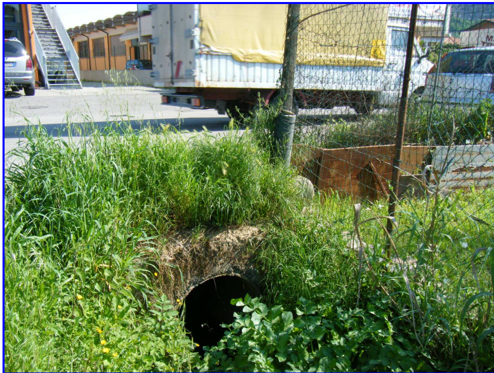
Figura 9 – Tubazione a valle di Via Arno (Ø 80 cm)
