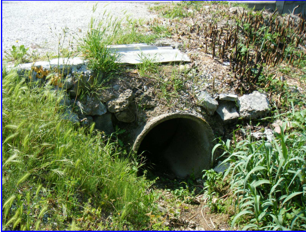
Figura 8 – Tubazione a monte di Via Arno (Ø 80 cm)
